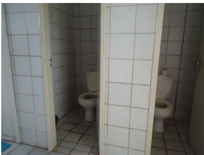
Figura 6. Instalações Sanitárias. Acervo Pessoal
