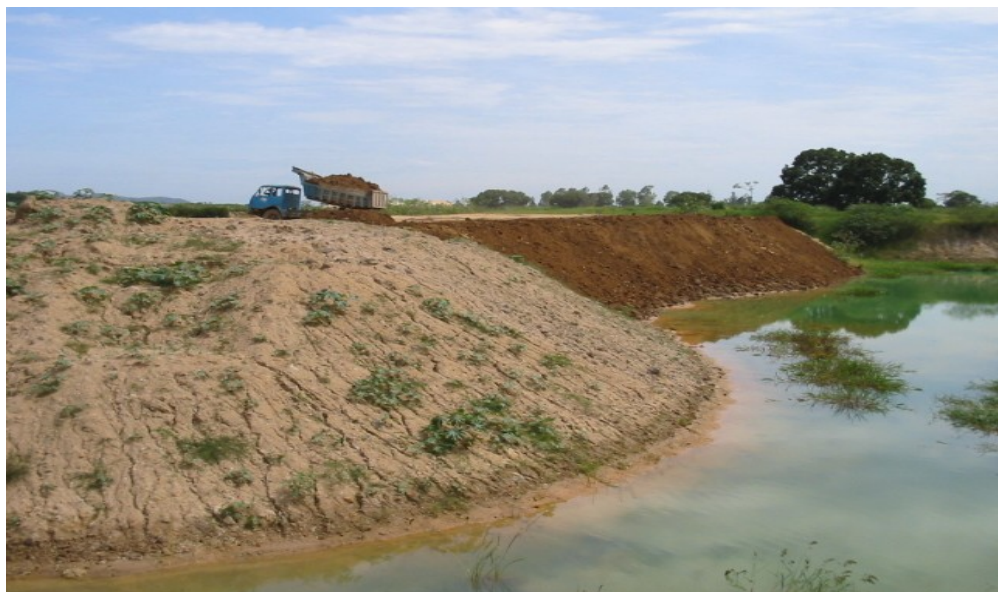
Figura 5 - Construção do talude.
