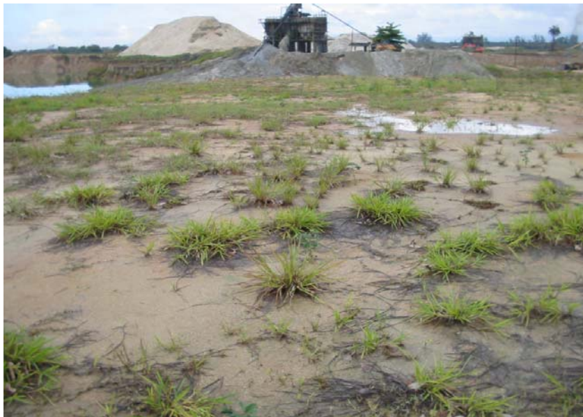
Figura 9 - Área de rejeito pronta para o plantio.
