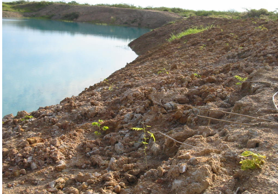
Figura 11 - Plantio em talude de LFN 30 DAP.
