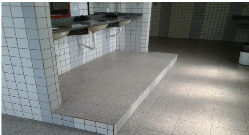
Figuras 15 e 16: Banheiro feminino do P1
