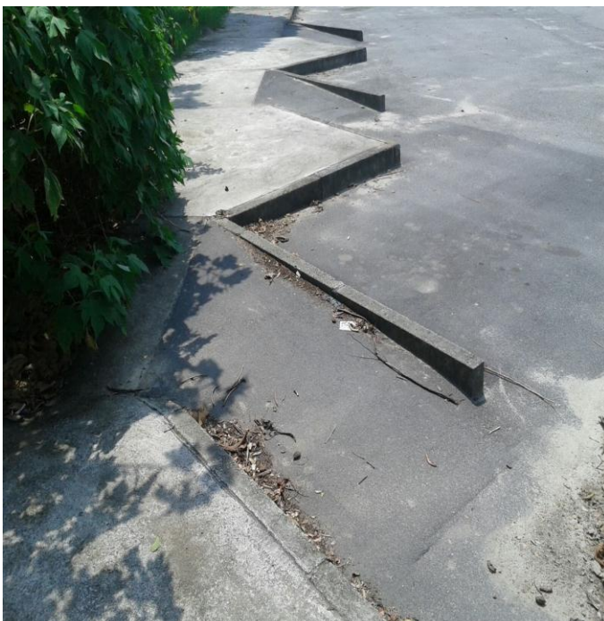
Figura 20: Rampa de acesso à entrada lateral do IE.
