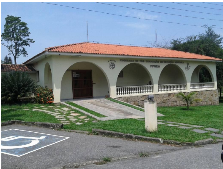
Figura 13: Prédio Sede do PPGEA/IA
