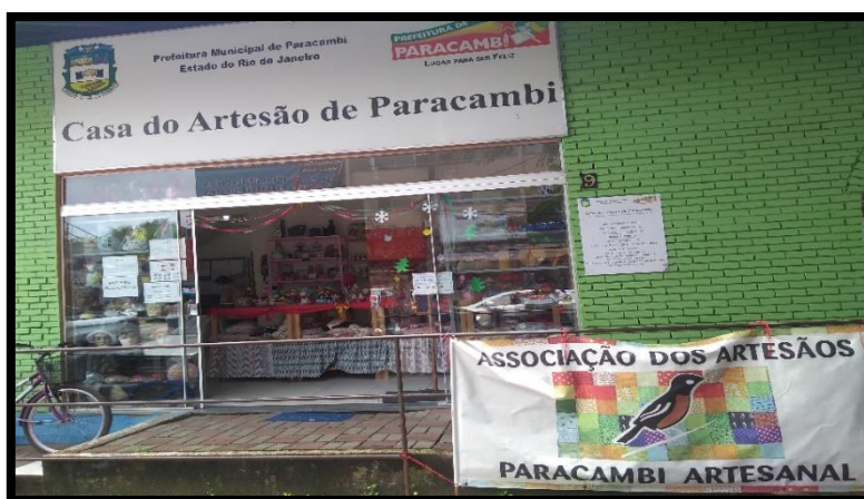
Figura 40- Fachada da Casa do Artesão de Paracambi na reabertura
