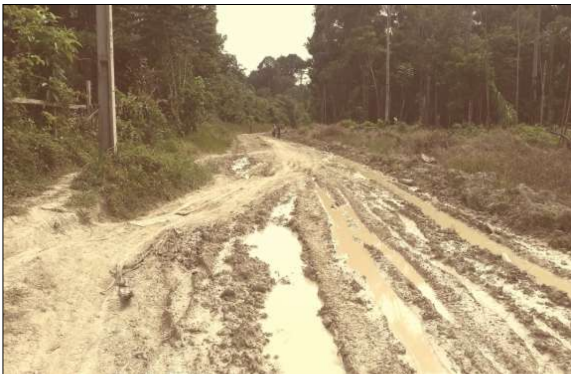
Figura 05. Condições de acesso a estradas no assentamento
