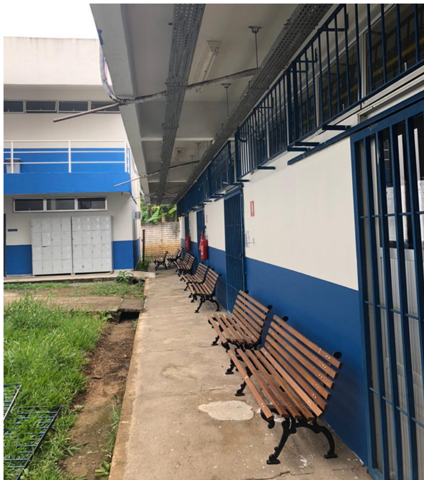
Figura 10 – Corredor de acesso aos laboratórios e ao prédio novo Fonte: Arquivo pessoal da autora, 2021.
