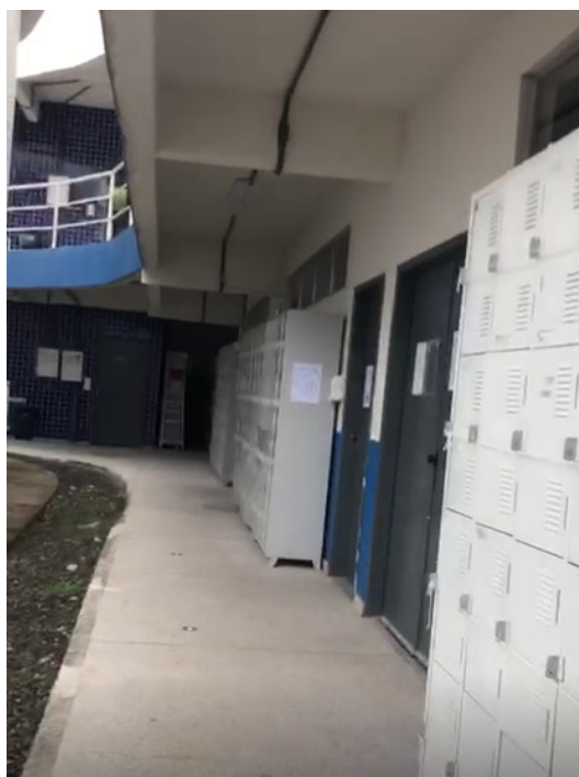
Figura 3 – Corredor do prédio com salas de aula Campus Valença do Cefet/RJ Fonte: Arquivo pessoal da autora, 2021.
