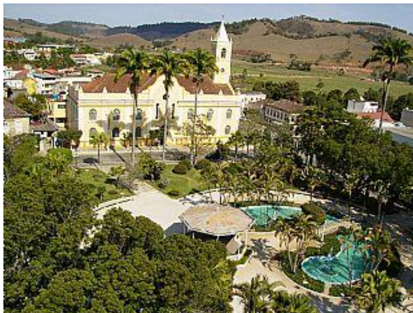
Figura 2 – Vista panorâmica da Praça Dr. Último de Carvalho (Centro de Rio Pomba)
