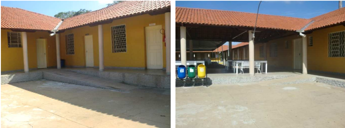
Figura 3 e 4 -Parte interna do Prédio de aulas I- acesso às salas de aulas e laboratórios
