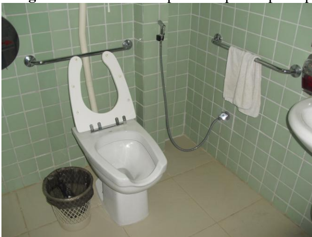
Imagem 20: Banheiro adaptado do prédio principal
