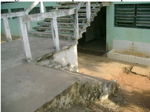
Imagem 08: Escadas para acesso ao prédio do alojamento masculino
