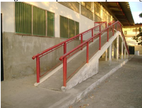
Imagem 05: Rampa de acesso ao prédio de agroindústria
