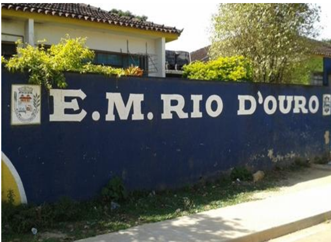
Figura 6 – Fachada externa da EMRD
