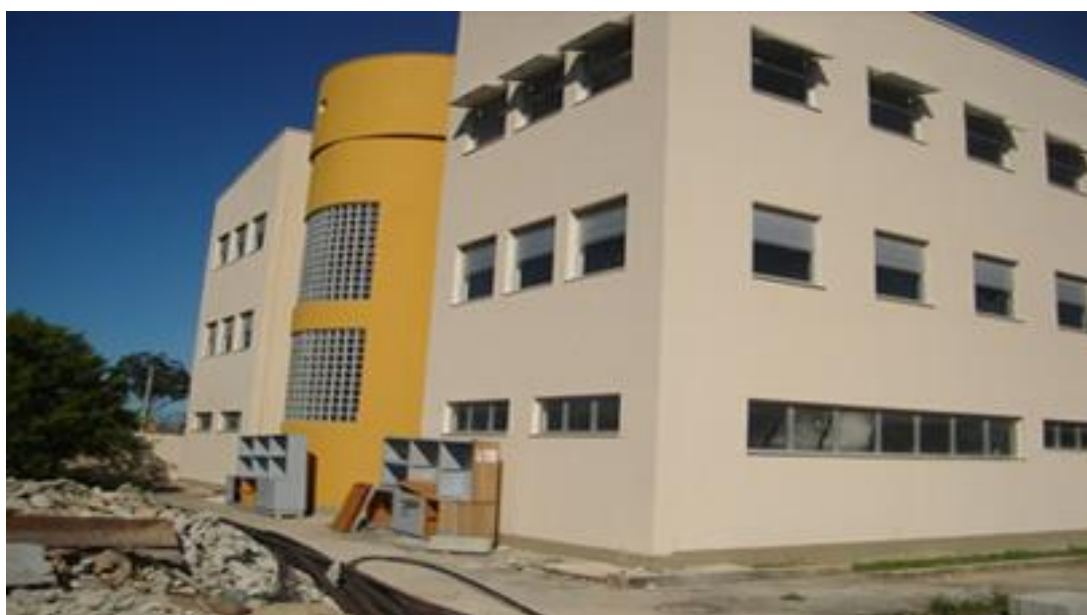
Imagem 35: Construção do novo prédio da E.M. Adalgisa Nery Fonte: < serverio.com.br/educacao-e-saude >. Acesso em 13 nov. 2017
