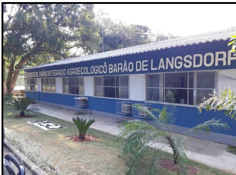
Figura 5 – Fachada do pavilhão 1 do CEIABL Fonte: A autora
