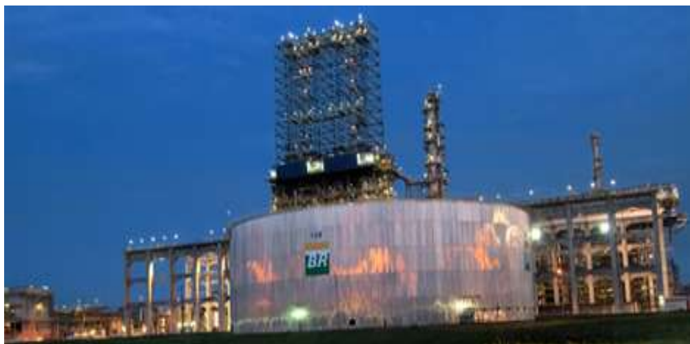
FIGURA 7- Unidade de Coqueamento Retardado e Tanque Maracanã 128
