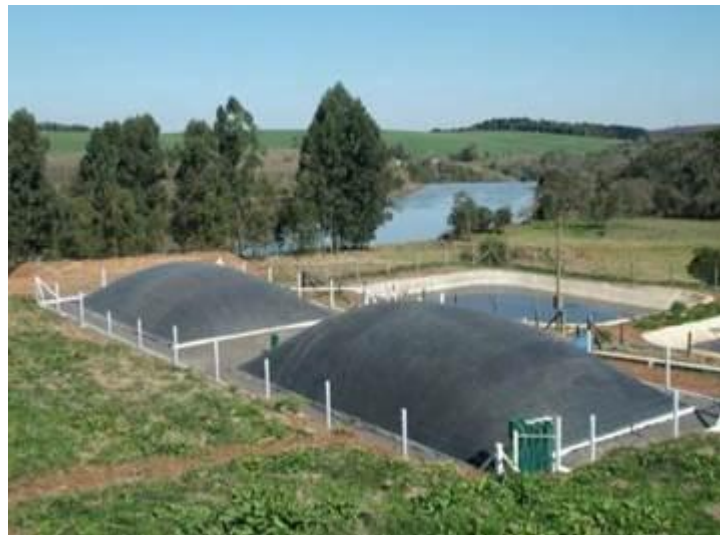
Figura 3. Biodigestor modelo Canadense. Fonte: Site Aqualimpia (2016)
