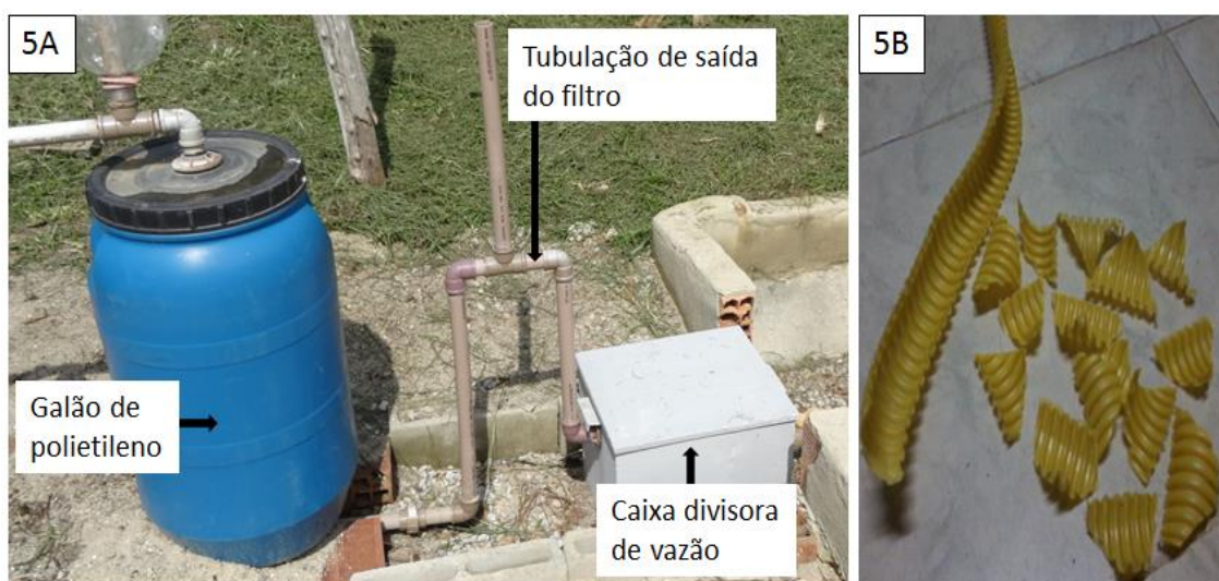
Figura 5. A: detalhe do galão de polietileno, tubulação de saída do filtro responsável em manter o galão parcialmente saturado e da caixa de passagem divisora de vazão. B: material filtrante adotado.
