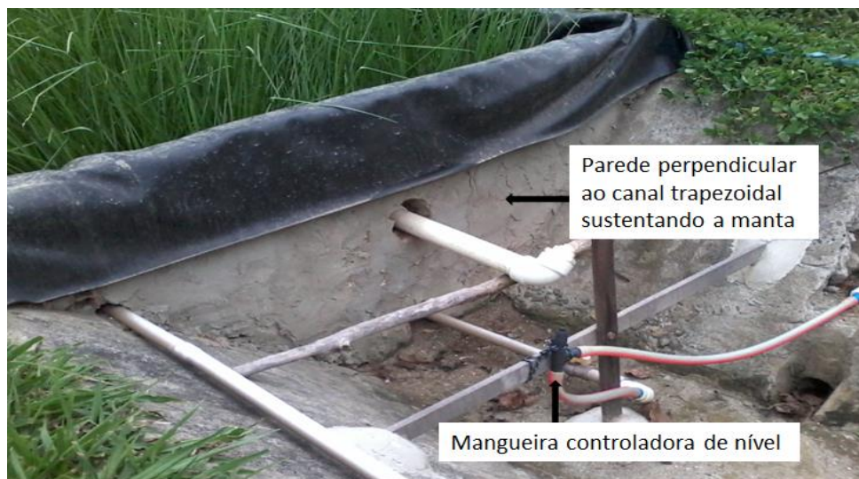
Figura 7. Detalhe do canal trapezoidal de concreto, da parede perpendicular ao seu comprimento sustentando a manta de impermeabilização e da mangueira controladora de nível.
