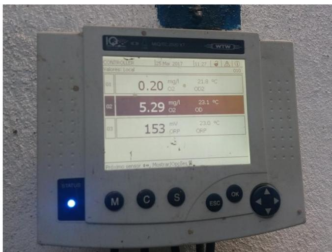
**Figura 9** – Equipamento para o monitoramento do oxigênio dissolvido
