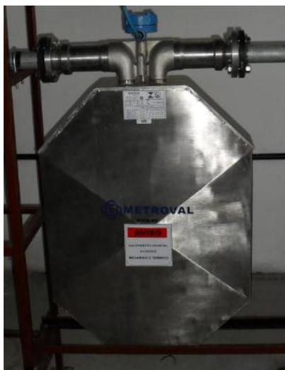
**Figura 22:** Foto do medidor de vazão e densidade coriollis da unidade.
