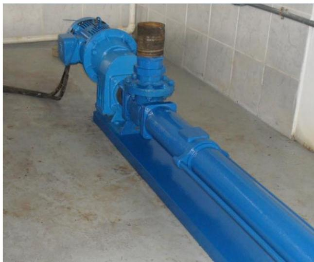
**Figura 24:** Bomba helicoidal de 25HP e 12Kgf/cm<sup>2</sup> de pressão de descarga.
