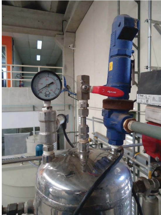
Figura 29 – Instrumentação no tanque de pressão. Fonte: O autor.
