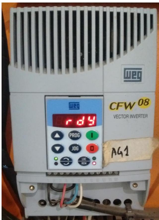
Figura 24 - Inversor de frequência. Fonte: o Autor
