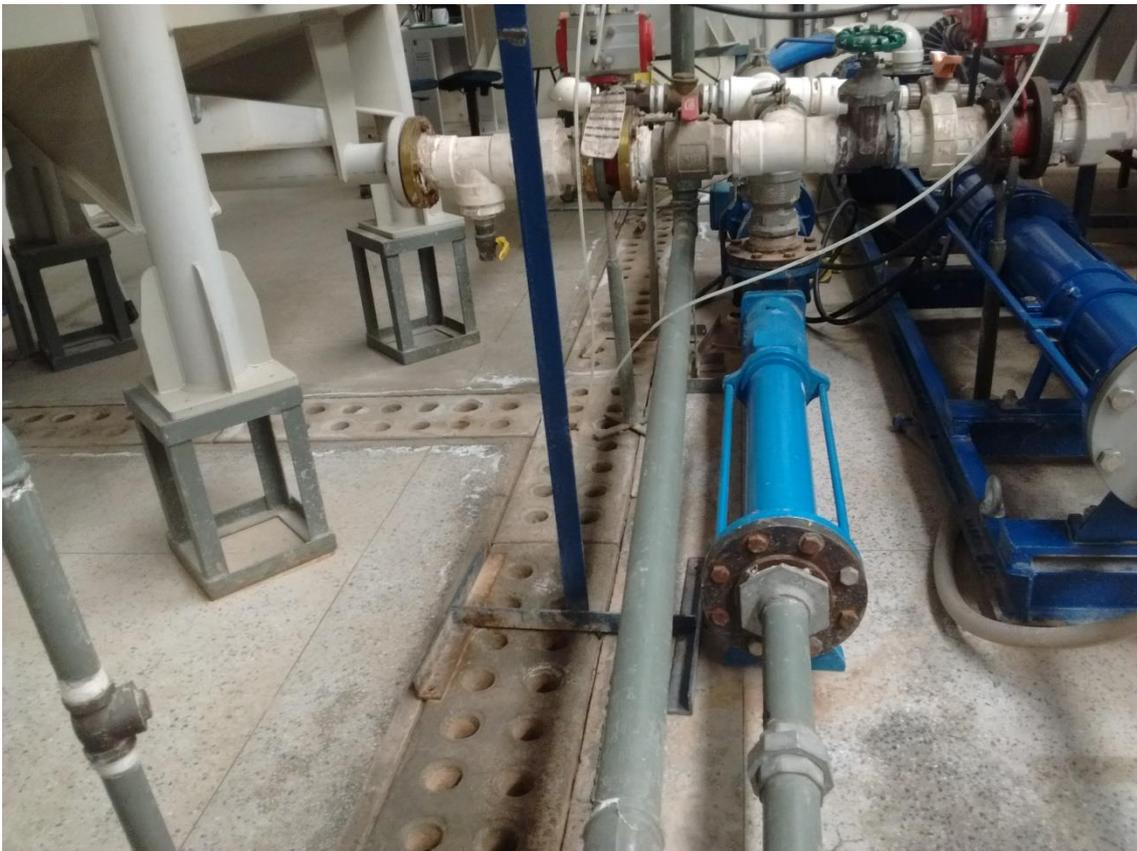
Figura 12 - Bomba Helicoidal conectada aos tanques. Fonte: o Autor.
