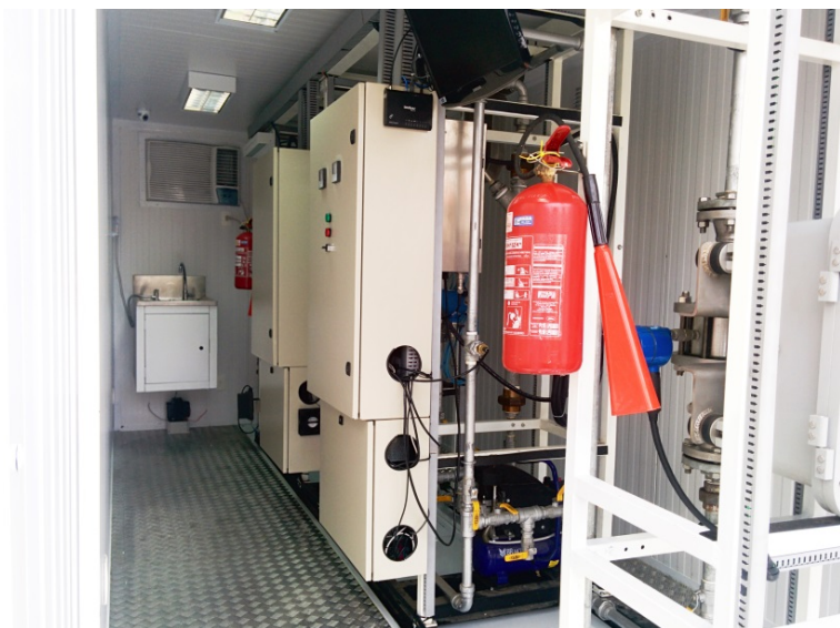
Figura 72. Fotos do interior do container com as linhas hidráulicas e sensores instalados
