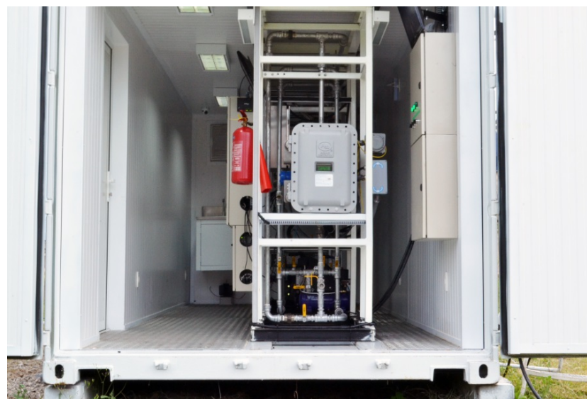
Figura 72. Fotos do interior do container com as linhas hidráulicas e sensores instalados
