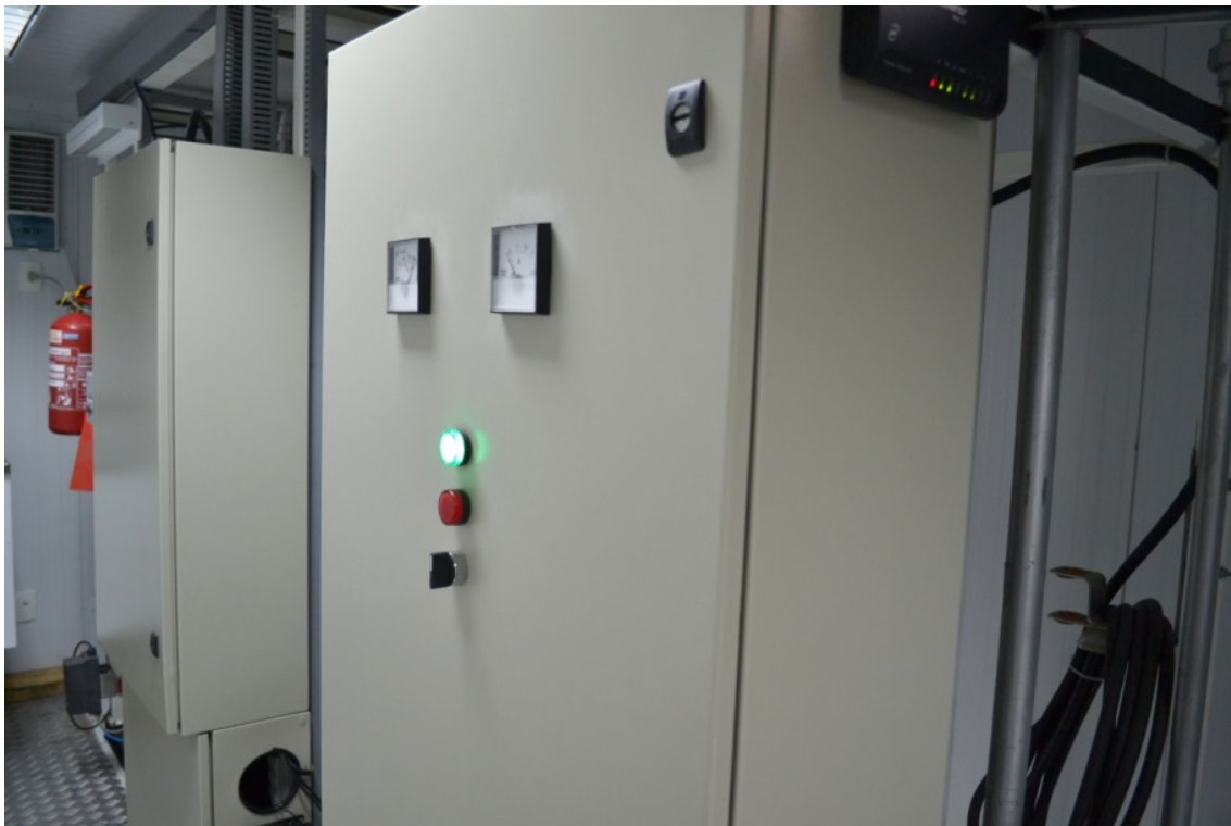
Figura 74. Foto do quadro de automação, à frente, e quadro de inversores de frequência e comandos de luz, ar e exaustor, ao fundo.
