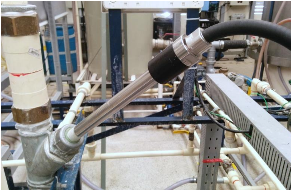
Figura 58. Sonda do FBRM instalada na tubulação do loop de Magalhães et al. , 2014.
