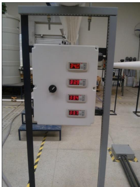
Figura 36 - Foto do painel de leitura dos sensores de temperatura.
