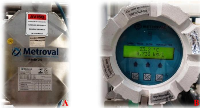
**Figura 27.** Densímetro. (A) Sensor mássico. (B) Display. Fonte: o autor.
