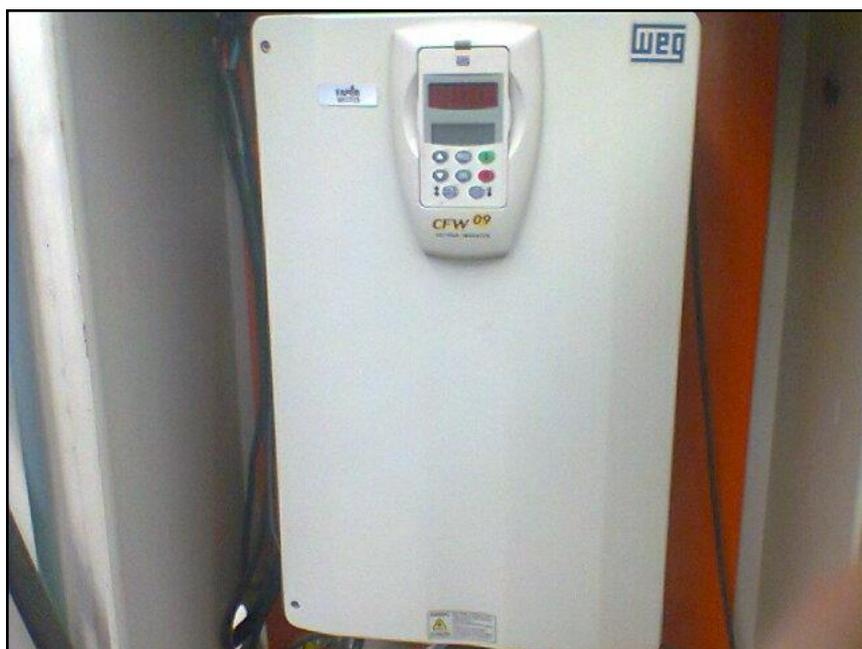
**Figura 6.** Inversor de frequência.
