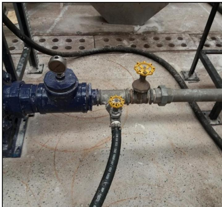
**Figura 5.** Divisão da tubulação horizontal em duas linhas.
