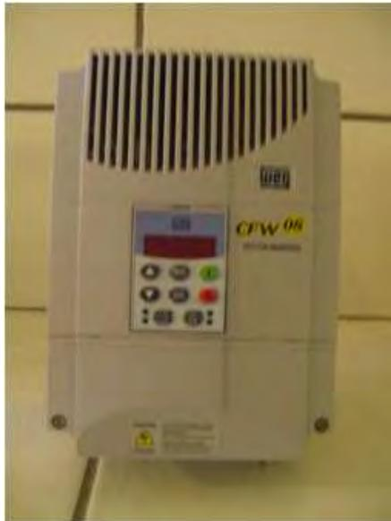
**Figura 3.5** - Inversor de frequência.
