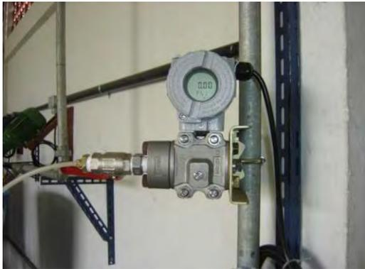
**Figura 3.8** - Transmissor de pressão manométrica.
