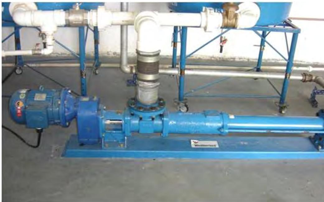
**Figura 3.2** - Bomba helicoidal de deslocamento positivo.
