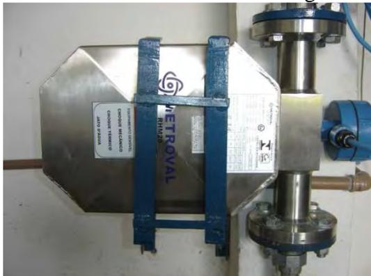
**Figura 3.6** - Medidor de vazão modelo RHM20.
