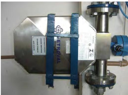
Figura 6 - Medidor de vazão modelo RHM20
