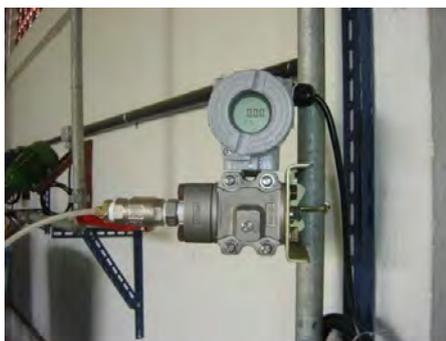
Figura 4 - Transdutor de pressão manométrico modelo LD301M.
