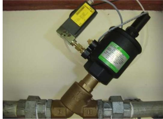
**Figura 3.9** - Válvula proporcional pra controle de vazão.
