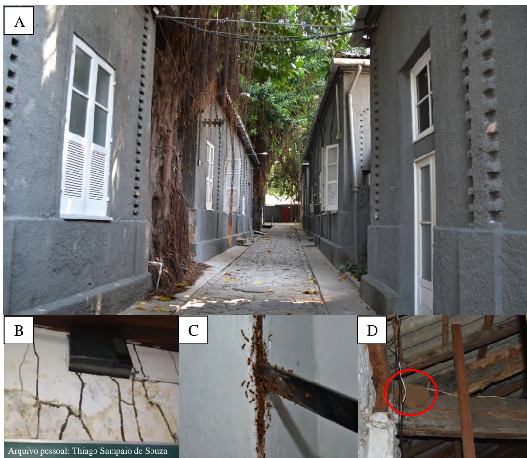
Figura 2. Danos causados por Nasutitermes corniger em prédio histórico da Universidade Estadual do Rio de Janeiro (UERJ)/ Campus Lapa, Rio de Janeiro, RJ: A. Escola Superior de Desenho Industrial; B. Túneis de N. corniger na parede interna de uma sala de aula alcançando o ar condicionado; C. Soldados de N. corniger ; D. Ninho policíclico incipiente, marcado em vermelho, encontrado no telhado.
