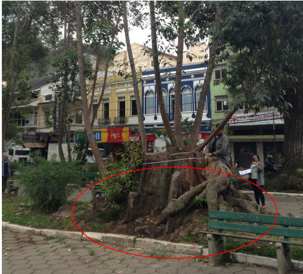
Figura 18. Toco de E. robusta com afloramento de raízes e brotações epicórmicas, elevando o solo e a calçada próximo a construção, PGV, Nova Friburgo, RJ.
