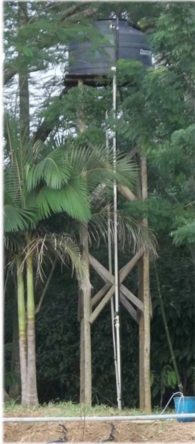
Figura 16: Reservatório de água.
