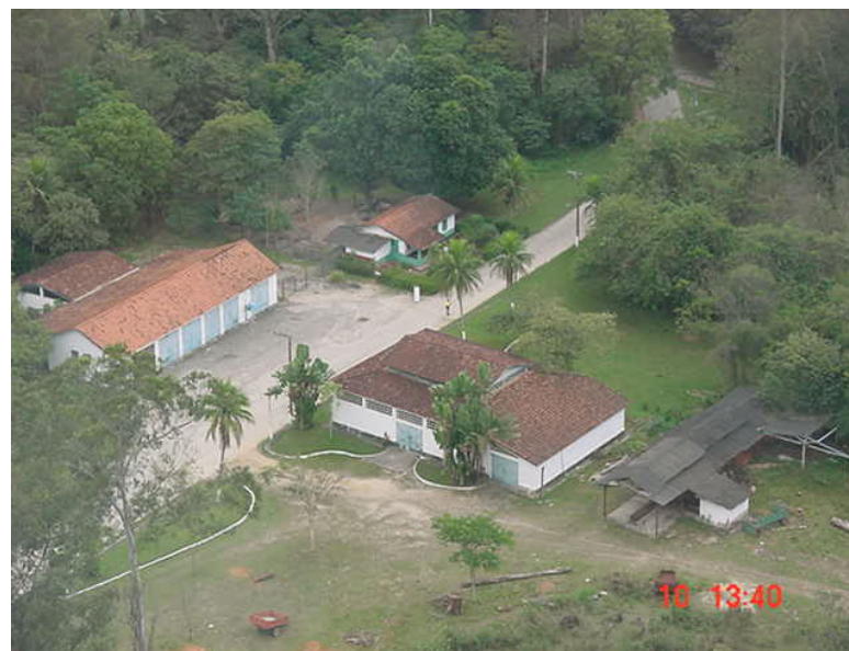
Figura 5 - Oficina de carpintaria – galpão garagem – oficina mecânica
