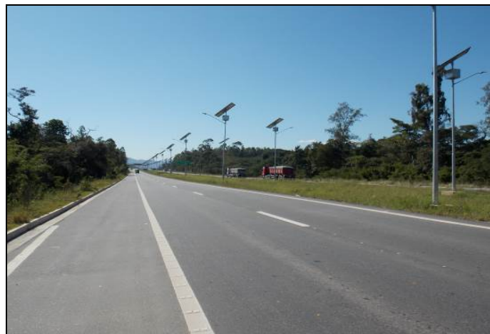
Figura 99 - Não há controle de velocidade, fixo ou móvel, nem defesa metálica na pista
