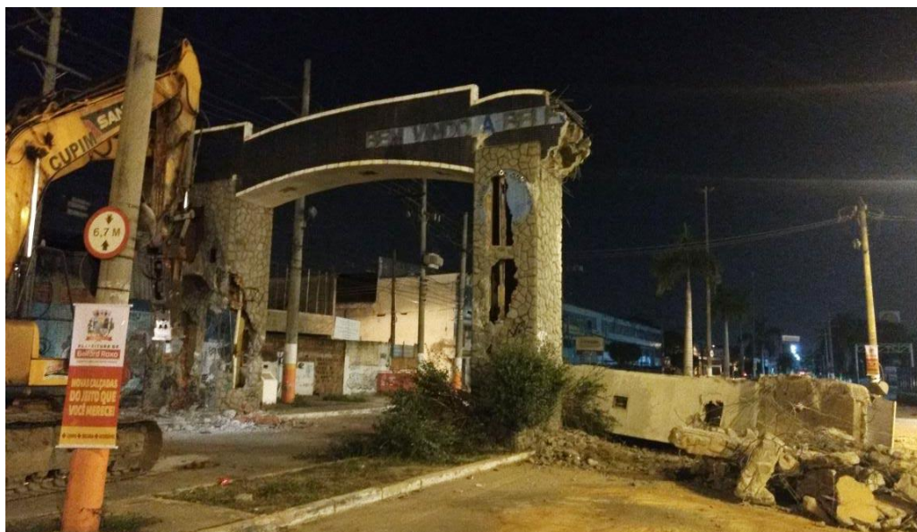
Figura 4 Imagem da demolição do antigo pórtico de entrada da cidade
