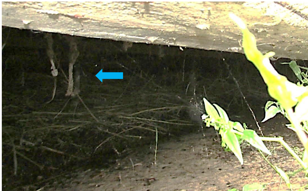
Figura 06: Parte inferior do galpão de criação de caprinos. Evidencia-se umidade e acúmulo de lixo e fezes sob o estrado. Seta azul indicando restos de abortamento sob o estrado. Propriedade no Recreio dos Bandeirantes, Rio de Janeiro. Abril de 2013.
