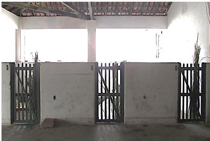
Figura 15: Baias de isolamento de pequenos ruminantes no Setor de Grandes Animais do Hospital Veterinário da Universidade Federal Rural do Rio de Janeiro.
