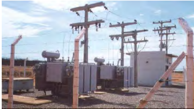
Figura 9 – Exemplo de uma subestação [11].
