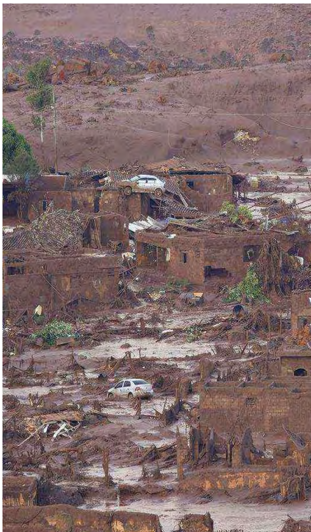
Figura 30: A lama. Povoado de Bento Rodrigues coberto de pelos rejeitos da barragem do fundão em Mariana. Fonte: www.em.com.br/app/galeria-de-fotos/2015/11/06/interna_gerais%2c1163623/tragedia-de-mariana-auxilio-para-afetados-acaba-em-plena-pandemia.shtml#ancora_galeria2 Acesso: 20/07/2020
