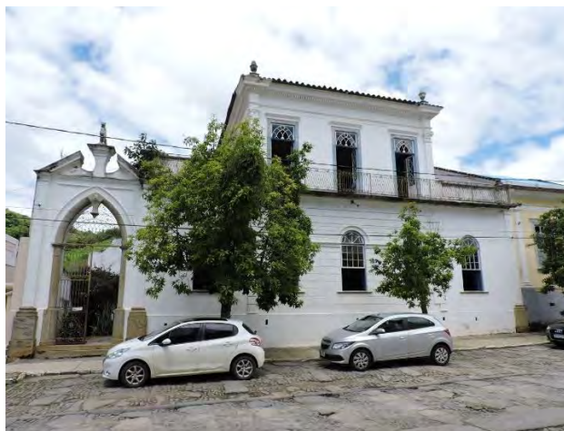
Figura 64: Casa Barão de Itambé.
