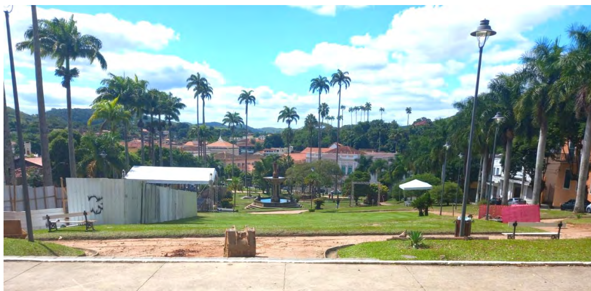
Figura 110: Obra para execução de rede de iluminação subterrânea.
