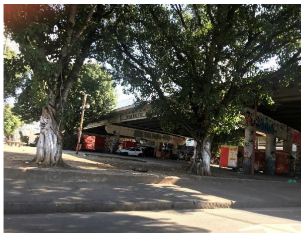
Fotografia 22. Viaduto Negrão de Lima.
