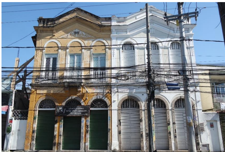
Fotografia 64. Fachada dos Sobrados nº 217 e nº 225.
