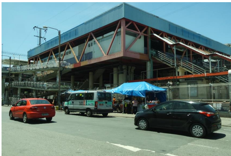
Fotografia 15. Estação de Madureira.
