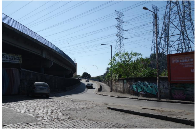
Fotografia 40. Viaduto Negrão de Lima em 2020.
