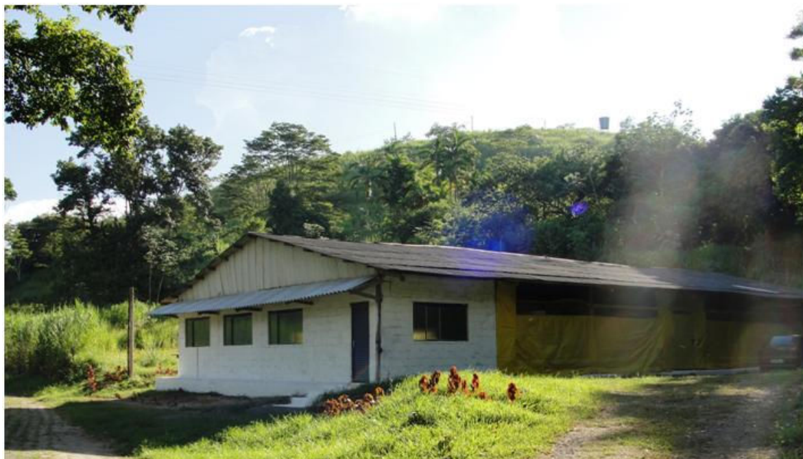
Figura 1. Visão externa do galpão experimental.
