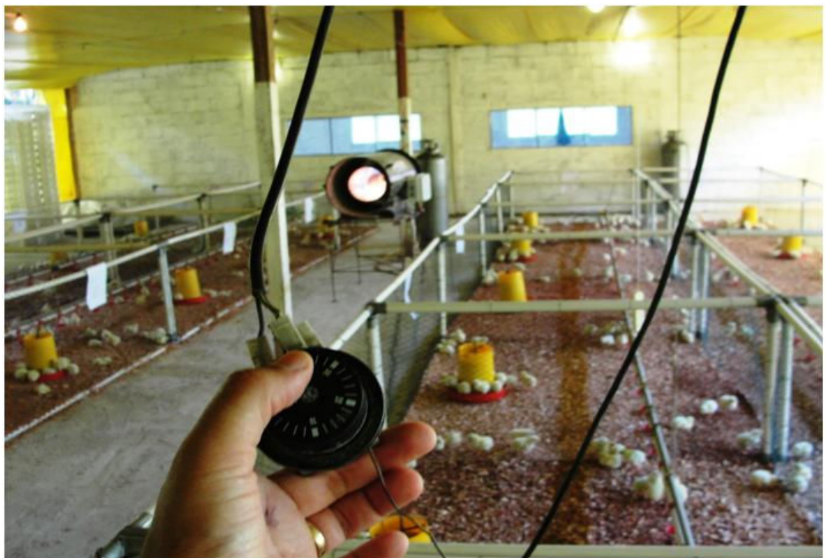
Figura 4. Regulador de temperatura do aquecedor.
