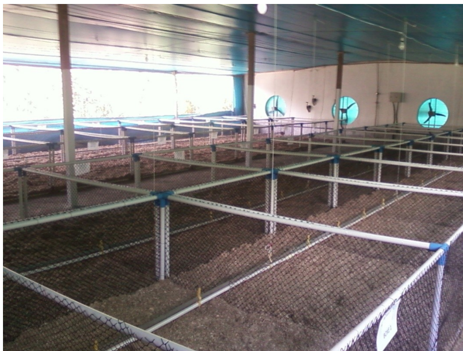
Figura 7: Vista interna do galpão experimental com saídas de ar e exaustores.
