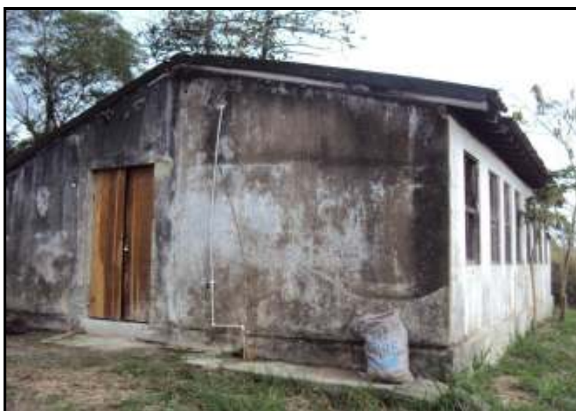
Figura 3 – Vista externa do galpão experimental
