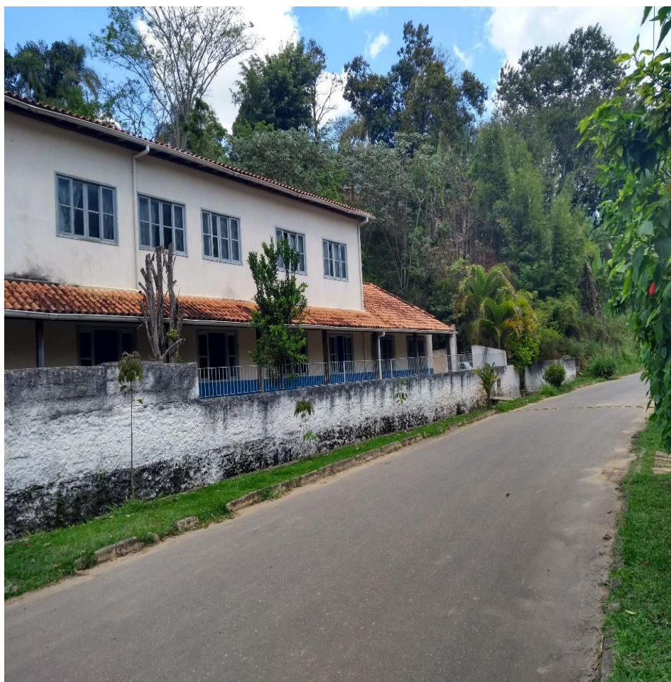
Figura 9: Vista Frontal da Escola
