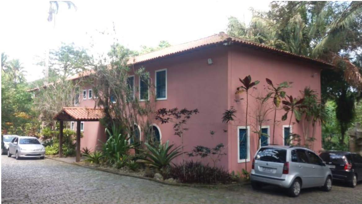
Figura 10 – Prédio da administração do SRBM
