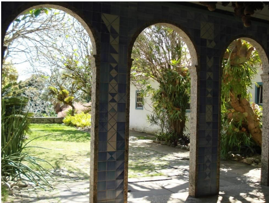
Figura 5 – Arcos de pedra de cantaria da Loggia
