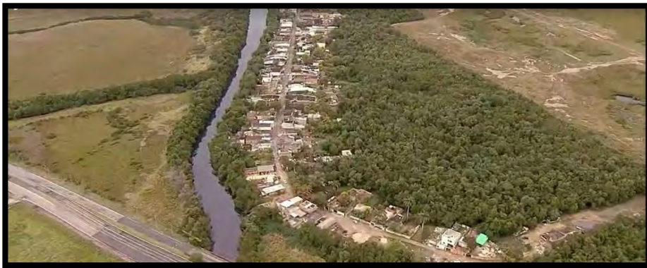
Figura 6 - Casas construídas de forma irregular às margens do Rio Piraquê
