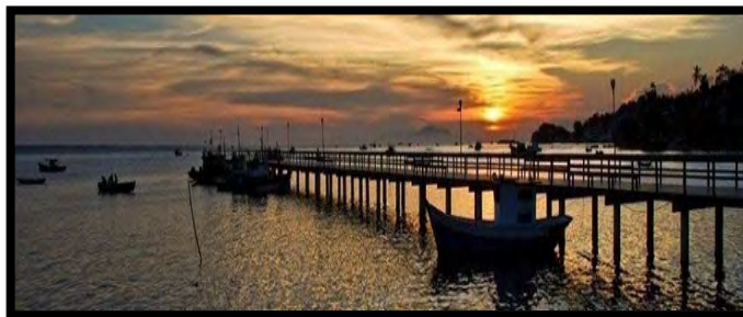
Figura 4 - Pier em Pedra de Guaratiba
