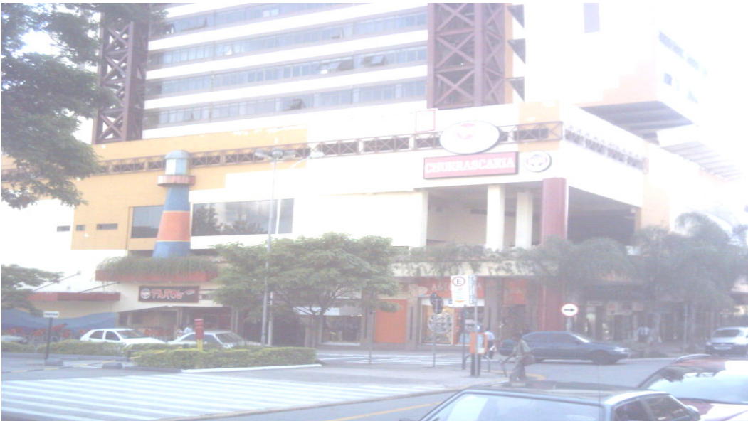
Fotografia nº 2 Entrada lateral à esquerda da entrada principal do Shopping
