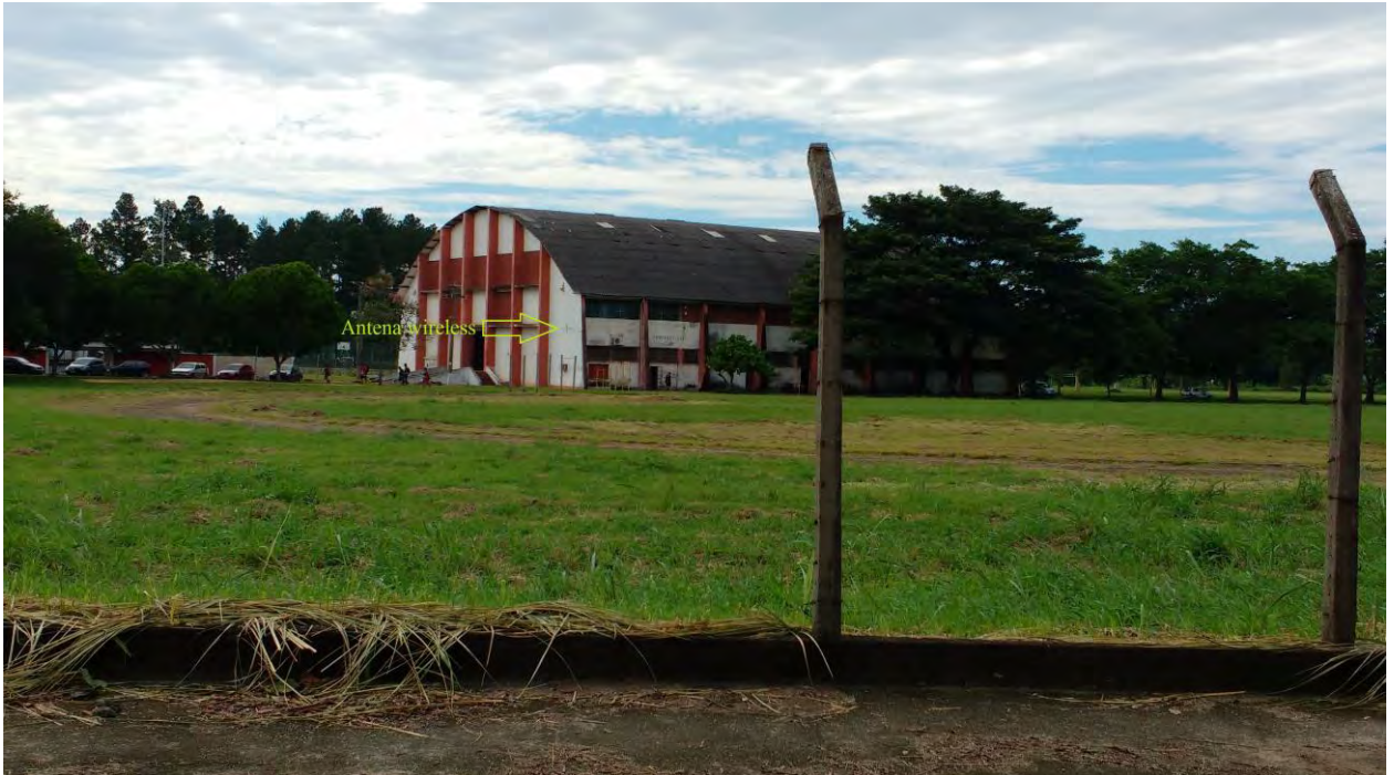
Figura 52. Antena Wireless instalada no Ginásio 1 da Praça de Desportos.
