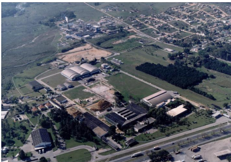
Vista Aérea do Parque Industrial Servatis
