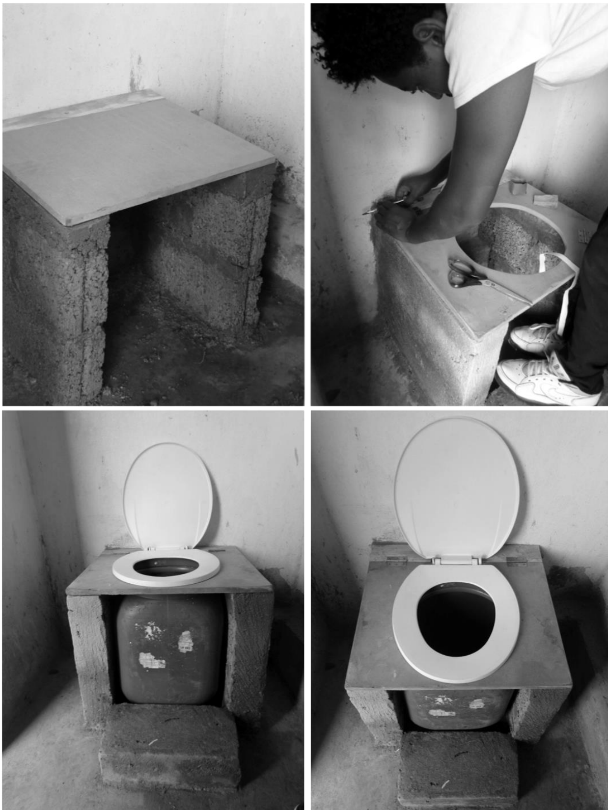
Figuras 48, 49, 50 & 51. Tampo de madeira serrado circularmente e encaixe com a bombona.
