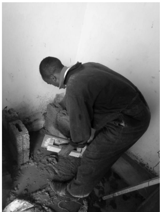
Figuras 46 & 47. Construção das paredes laterais
