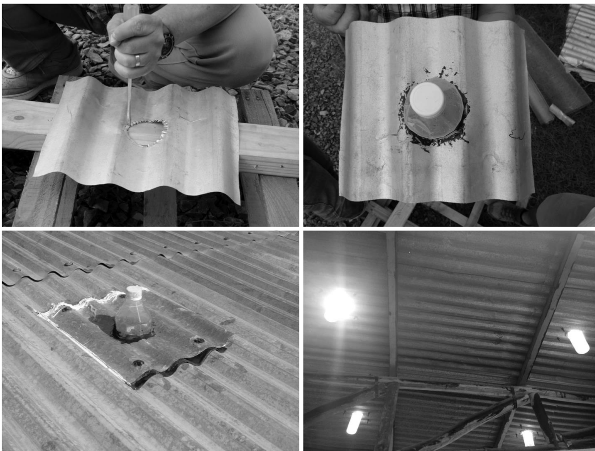
Figuras 40, 41, 42 & 43. Confeção das lâmpadas solares e luminosidade após a instalação.
