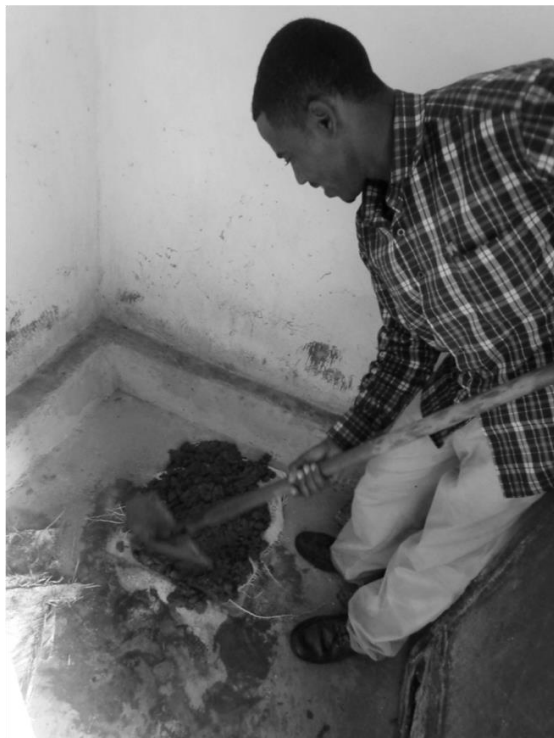
Figuras 44 & 45. Fechamento do antigo buraco das latrinas e revestimento com massa fina.
