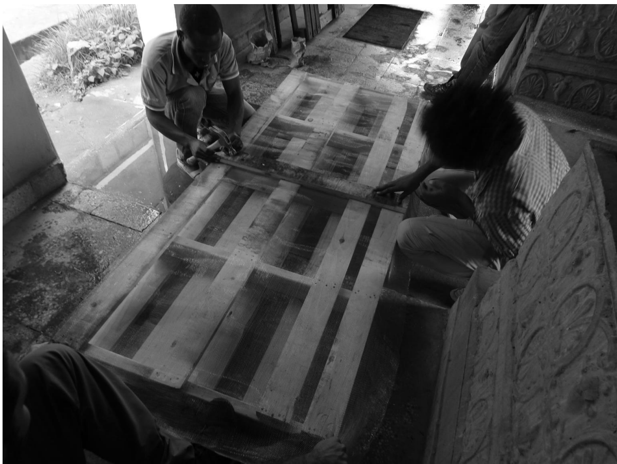
Figura 22. Revestimento com tela mosquiteira nas paredes da caixa de compostagem.
