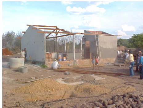
Foto 12- CPP NAZARÉ em obras- N.S.Antônio/PI
