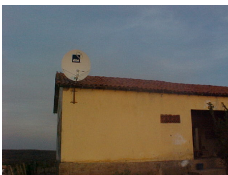
Foto 13- Antena para acesso à Internet na escola
