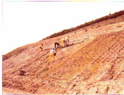
Figura 3. Operação de carregamento dos sacos de aniagem.
