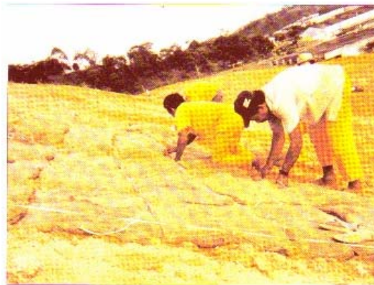
Figura 4. Fixação dos sacos no talude.
