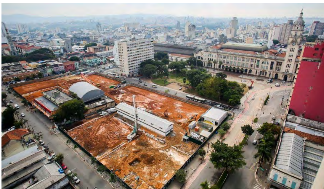
Figura 37 - Canteiro de obras da construção do Complexo Júlio Prestes, 2016
