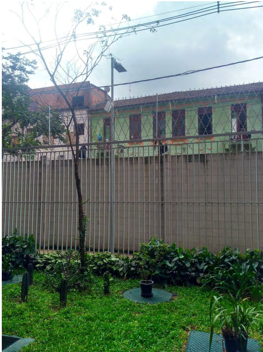
Figura 45 - Imagem dos muros com grades do Complexo Júlio Prestes, fotografia tirada dentro do empreendimento, 2021
