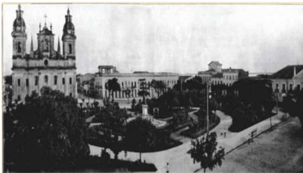
Figura 01 – Vista geral da Praça Dom Frei Caetano Brandão, com destaque para a Catedral da Sé de Belém.
