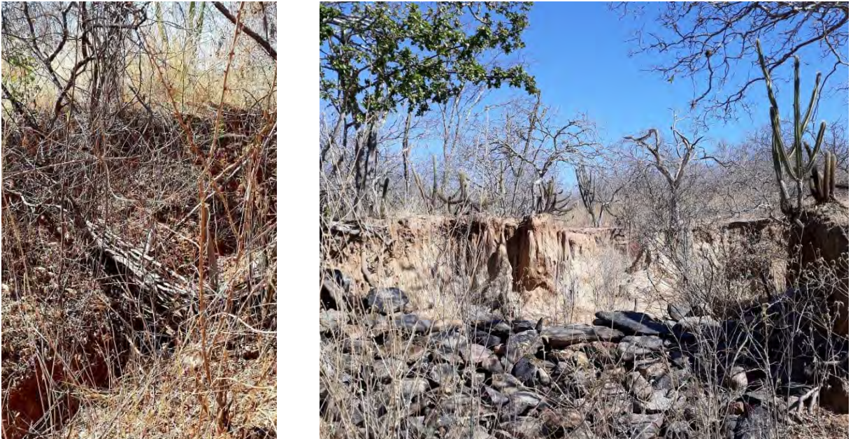
Figura 8 (a e b): Barragens de pedra e estruturas de paliçada, construídas na comunidade de Bom Princípio, para conter o assoreamento.
