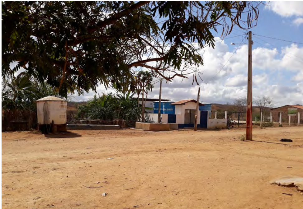
Figura 9: À esquerda, o antigo poço da comunidade, que ainda é utilizado, e à direita a infraestrutura de dessalinização promovida pelo Programa Água Doce, na comunidade de Bom Princípio.
