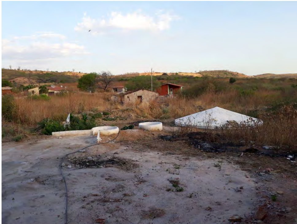
Figura 10: Cisterna de enxurrada na comunidade Sítio Carcará, município de Potengi.
