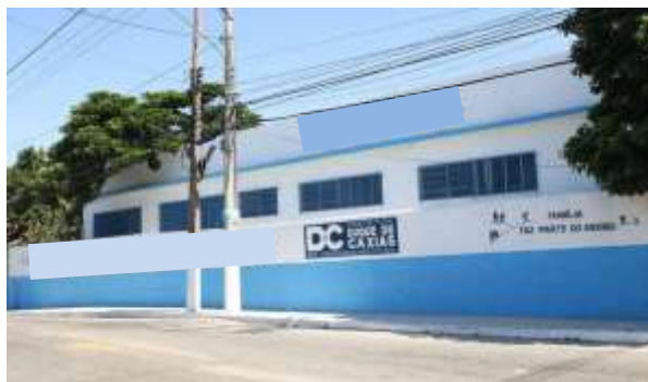
Fachada da escola na beira de pista de veículos leves e pesados. (Fonte: Arquivo de fotos da Escola)
