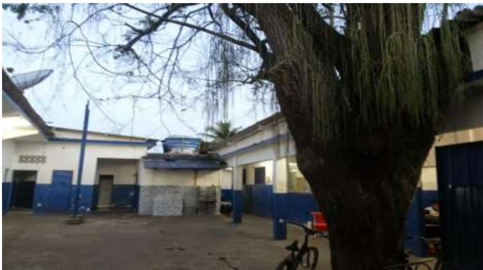
Área interna da escola com pequeno espaço para circulação (Fonte: Arquivo de fotos da Escola)
